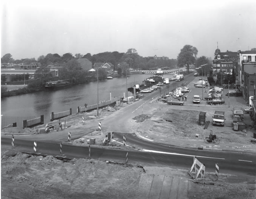
De voorheen opklapbare Paul Krugerbrug wordt verbouwd tot een vaste brug, 1982. Foto: Gemeentelijke Archiefdienst Utrecht.
